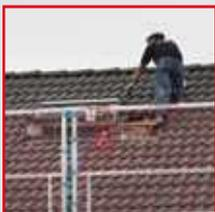
Einzigartige Sicherheit für die Arbeit auf Steil- und Flachdächern. Für Neigungswinkel bis zu 60° geeignet. 6 bis 12 Meter breite modulare Absturzsicherung mit nur 2 Stützen
