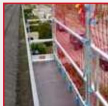
Geländerrahmen mit speziellen Fangnetzen. Arbeitsgerüst sowie Absturzsicherung. Problemlose und schnelle Montage
